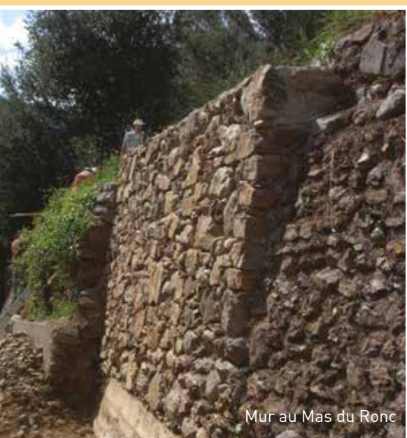
Mur au Valdeyron
