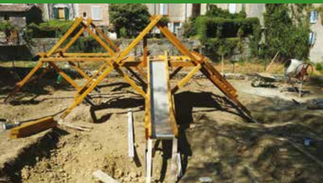
▲ La structure Odilo en cours d'installation au Grand Parc
