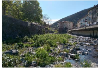
Banc végétalisé situé en rive gauche
