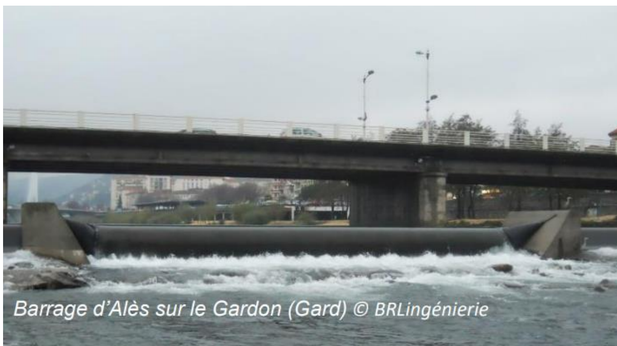
FIGURE 27 : EXEMPLE DU BARAGE ESCAMOTABLE D'ALES (BR LINGENIERIE)
