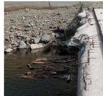
Seuil de l'Hérault après la crue de 2020 – en mauvais état avec un affouillement important sous le seuil et la présence des embâcles
