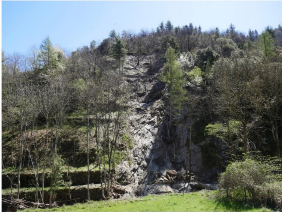
FIGURE 9 : GLISSEMENT DE TERRAIN SUR UN VERSANT DE TERRASSES ABANDONNEES SURVENU A L'OCCASION DE L'EPISODE METEOROLOGIQUE MEDITERRANEEN DU 19/09/2020 (MANSION, 2021)
