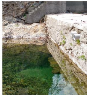
Seuil de l'Hérault après la crue de 2020 – en mauvais état avec un affouillement important sous le seuil et la présence des embâcles
