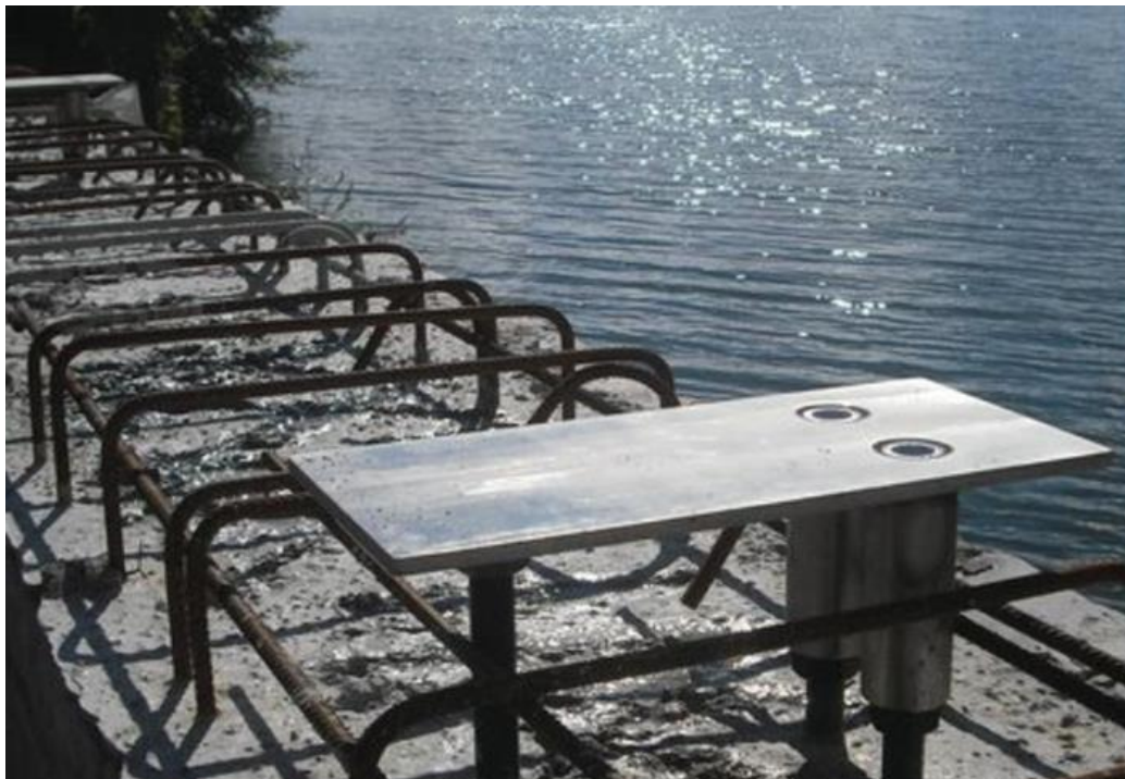
FIGURE 28 : EXEMPLE D'OUVRAGE A CLAPET METALIQUE
